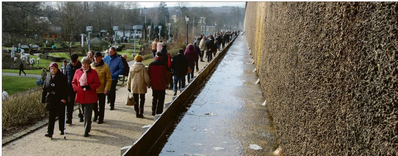
Am Gradierwerk wird Wasser über Schwarzdornbündel geleitet. Durch Verdunstung erhöht sich so die Salzkonzentration.
